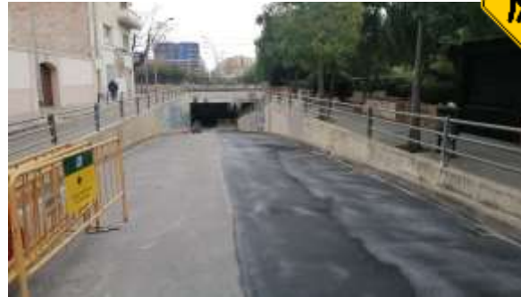
Fotografies durant l'obra ↓
