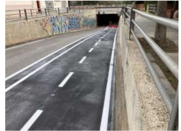
Fotografies de l'obra acabada ↓
