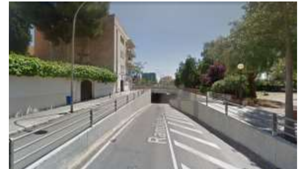
Fotografies de l'obra acabada ↓
