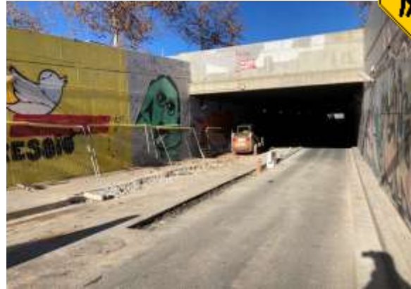
Fotografies durant l'obra ↓
