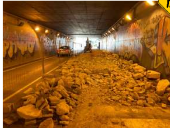
Fotografies durant l'obra ↓
