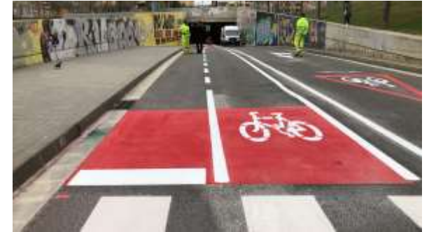
Fotografies de l'obra acabada ↓
