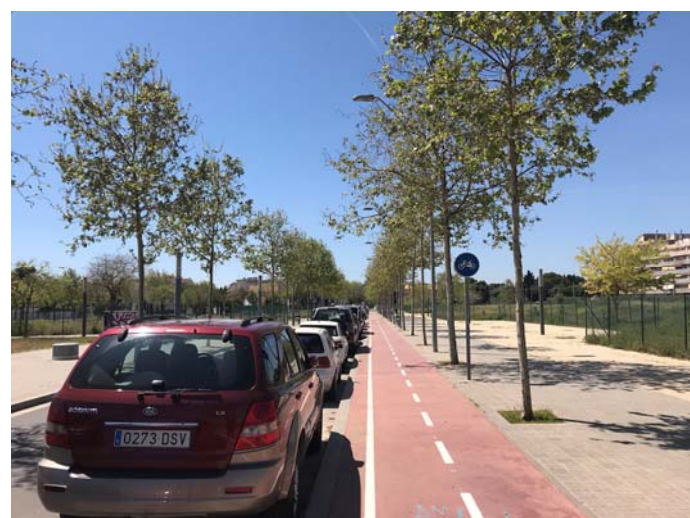
Via ciclista executada com a part del Projecte d'urbanització
