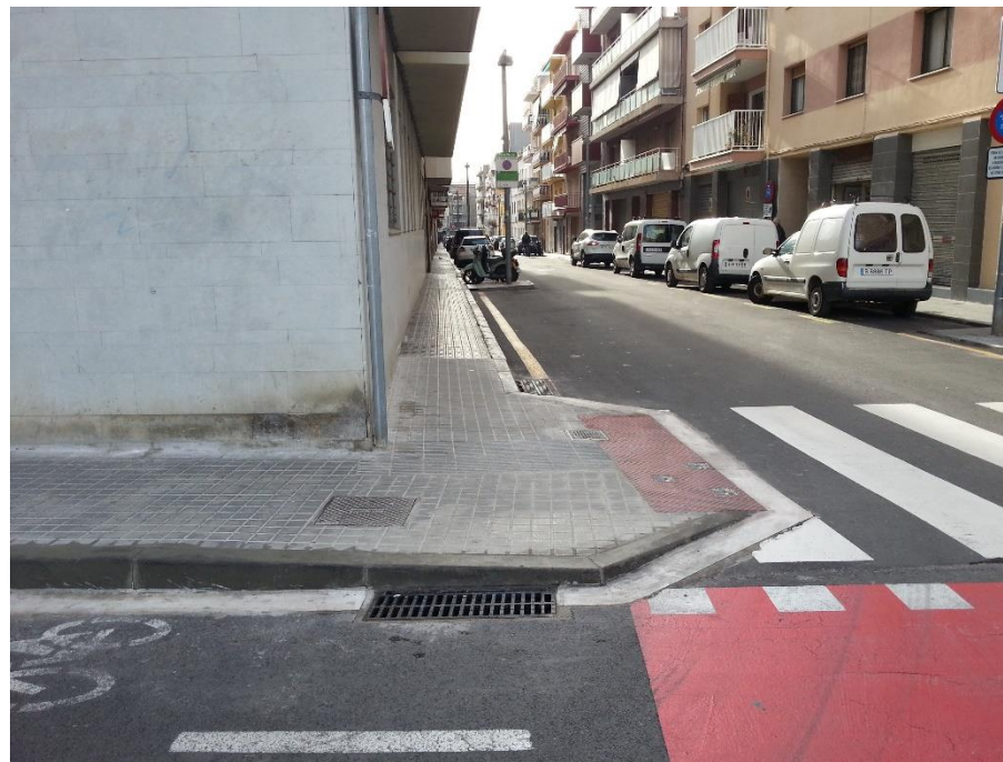
Construcció de nous embornals
