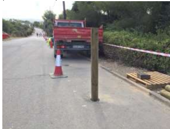
Obres en procés d'execució. Col·locació de pilones i corda per delimitar els vials ↓
