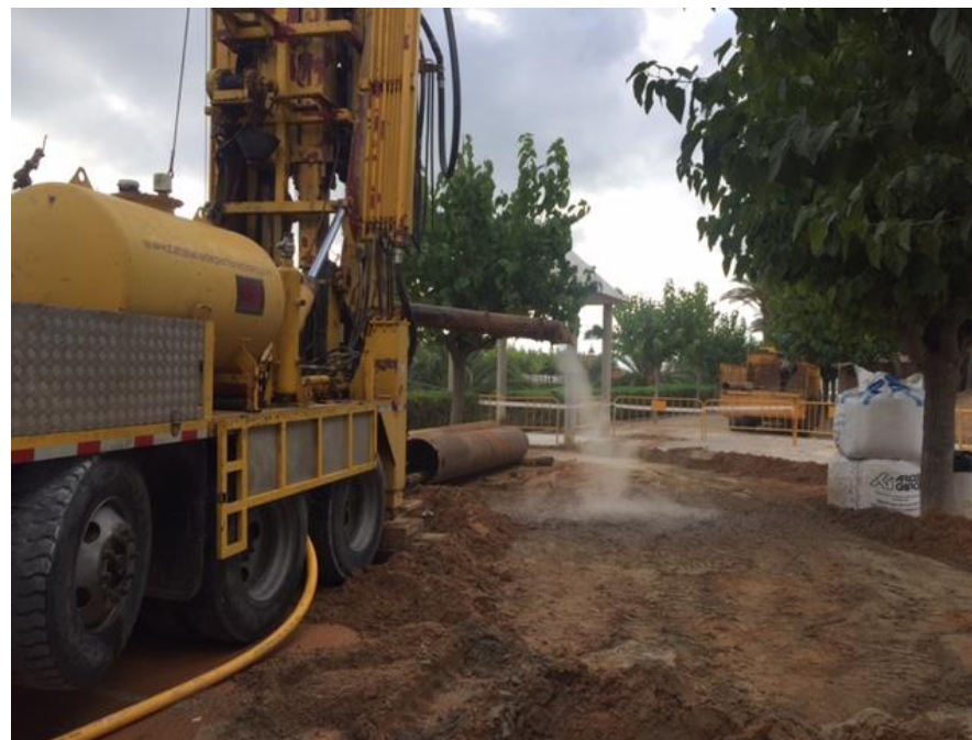
Execució de pous
