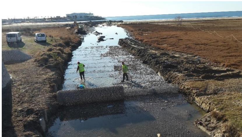
Instal·lació de gabions metàl·lics
