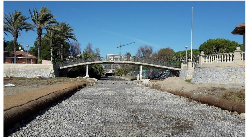
Instal·lació de biorolls i manta orgànica
