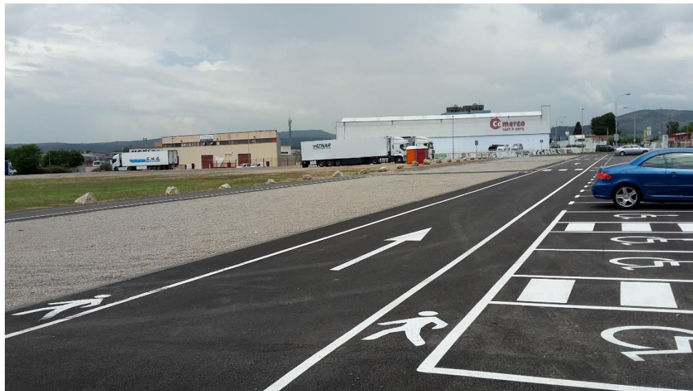
Vista de l'aparcament amb les pedres de delimitació
