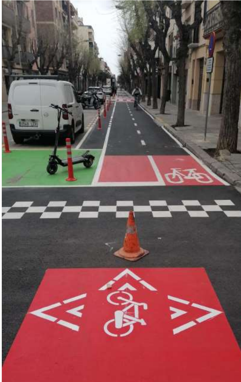
Cruïlla amb c. del Teatre. Obra acabada ↓
