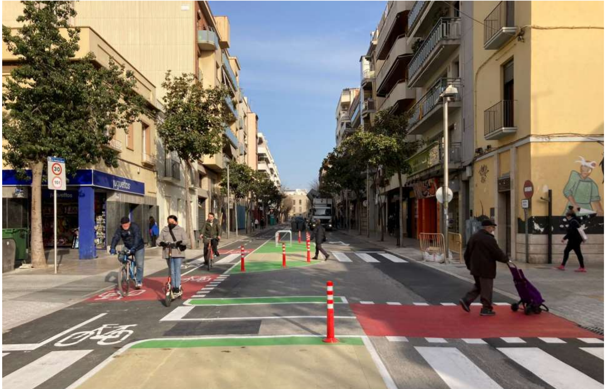
Cruïlla amb av. de Francesc Macià. Obra acabada ↓
