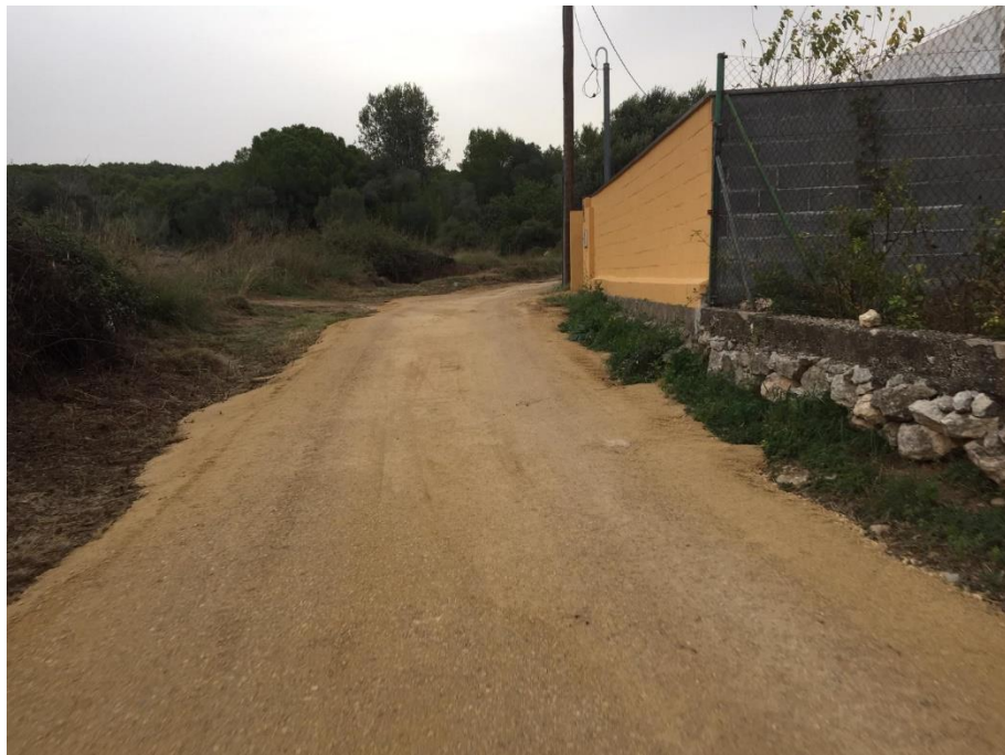
Camí d'enllaç entre camí del Mas Torrat i camí del Mas Tapet: desbrossament i anivellament del sòl.
