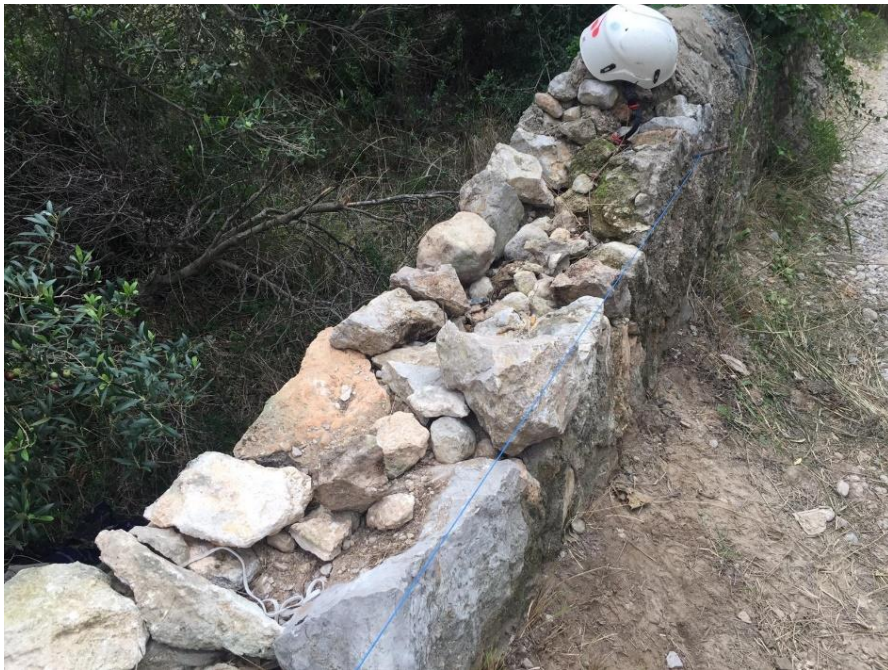
Camí de l'Ortoll: arranament de 75 m 2 de murs de pedra en sec
