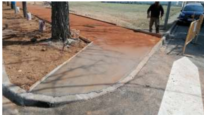
4. Obres a la vorera
