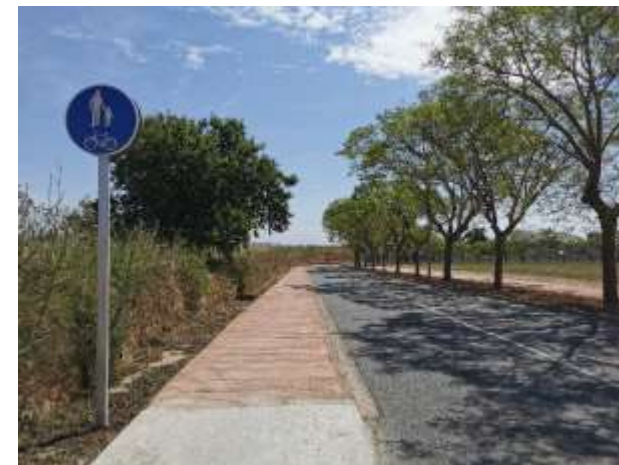
Començament a l'altura del carrer del Rasot.
