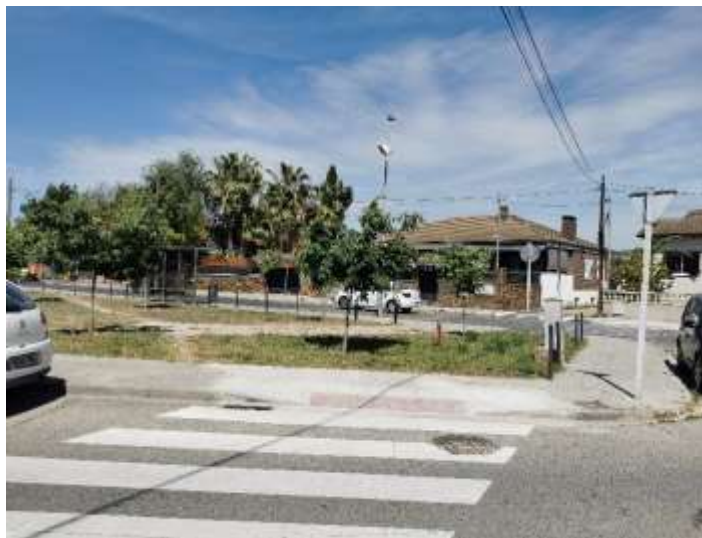
Dos rebaixos a pas de vianants del carrer del Riu Segura.
