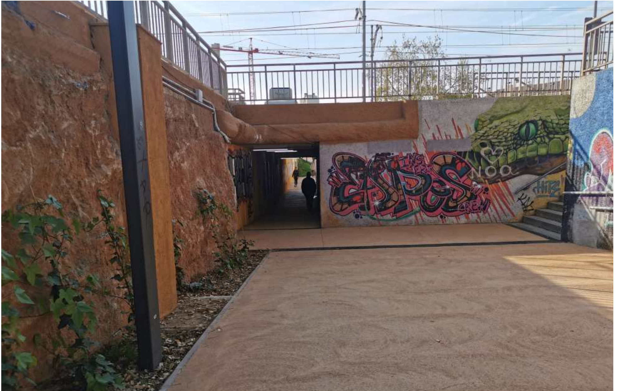
Pas sota via C/ Josep Coroleu. Obra acabada ↓
