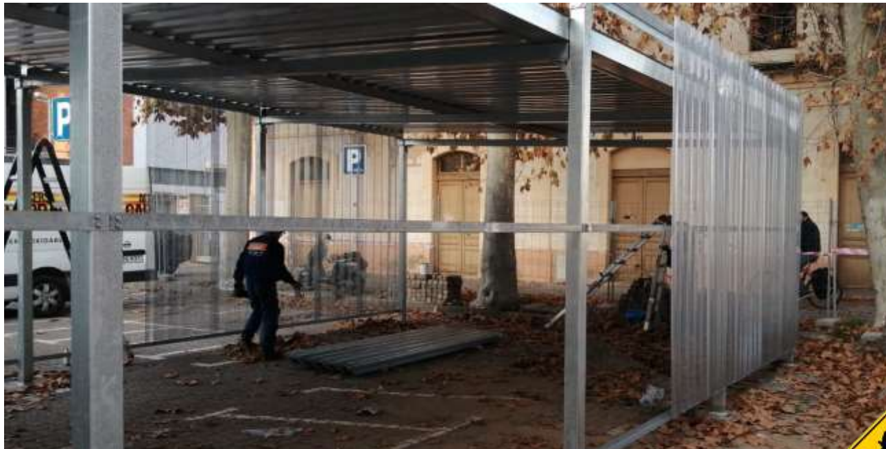
Fotografies de les obres de construcció de la cicloestació ↓
