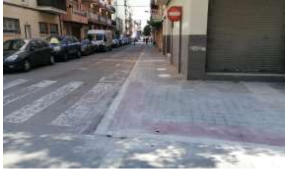
Rebaix a la rambla del Castell acabat ↓
