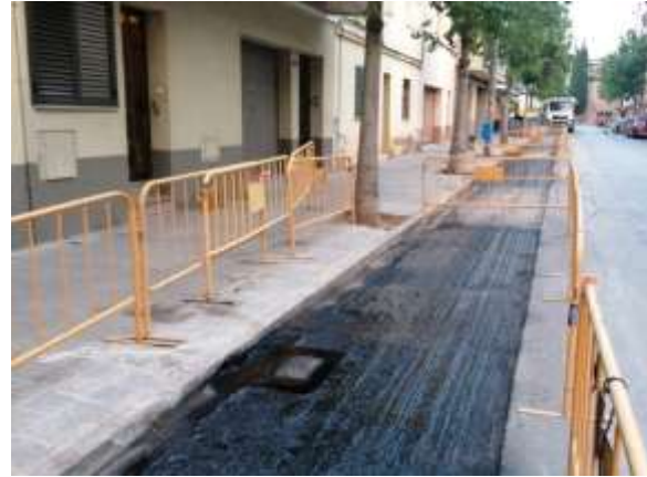
Reasfaltat a la rambla del Castell ↓
