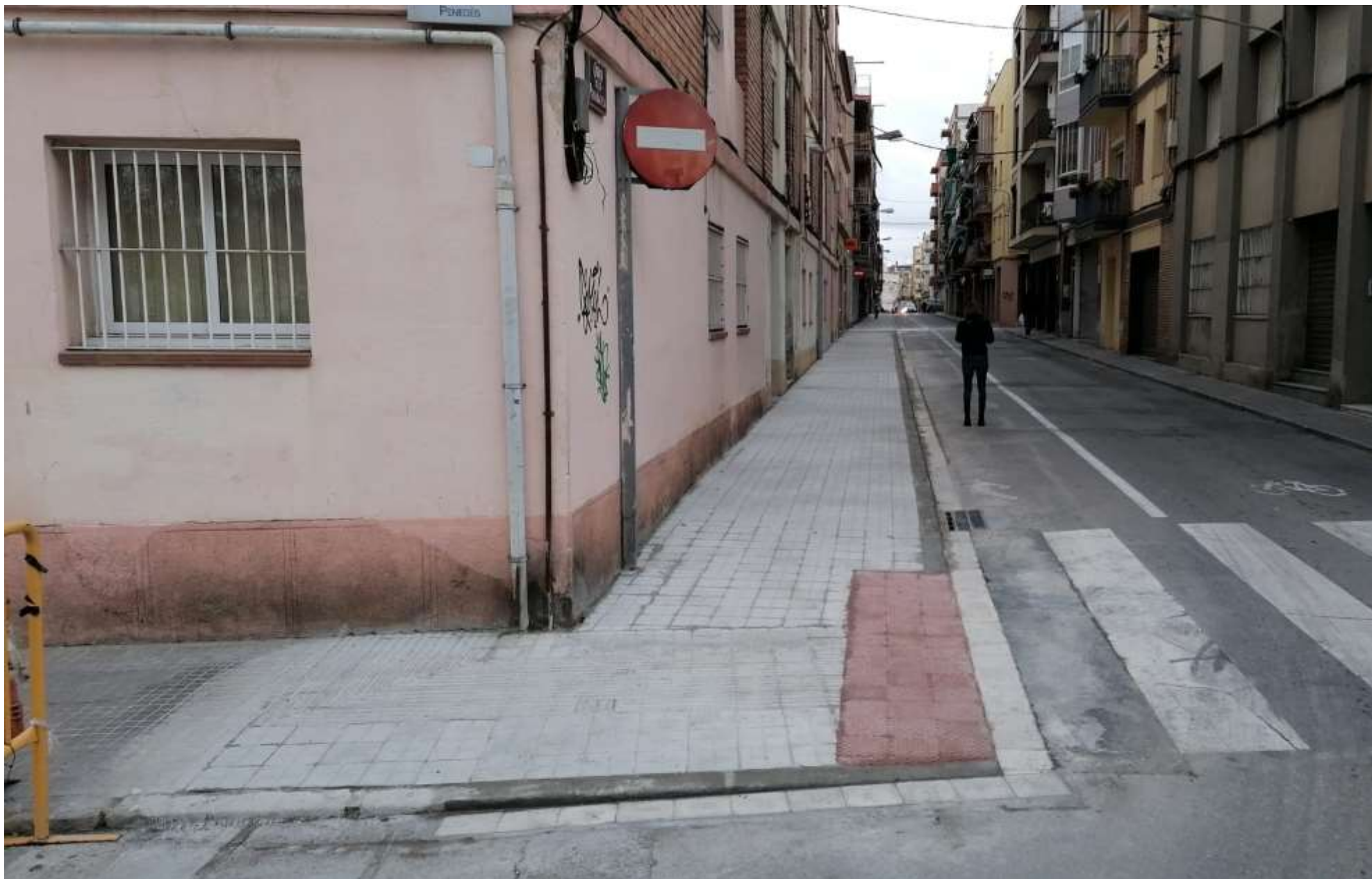
Carrer de la Providència. Obra acabada.
