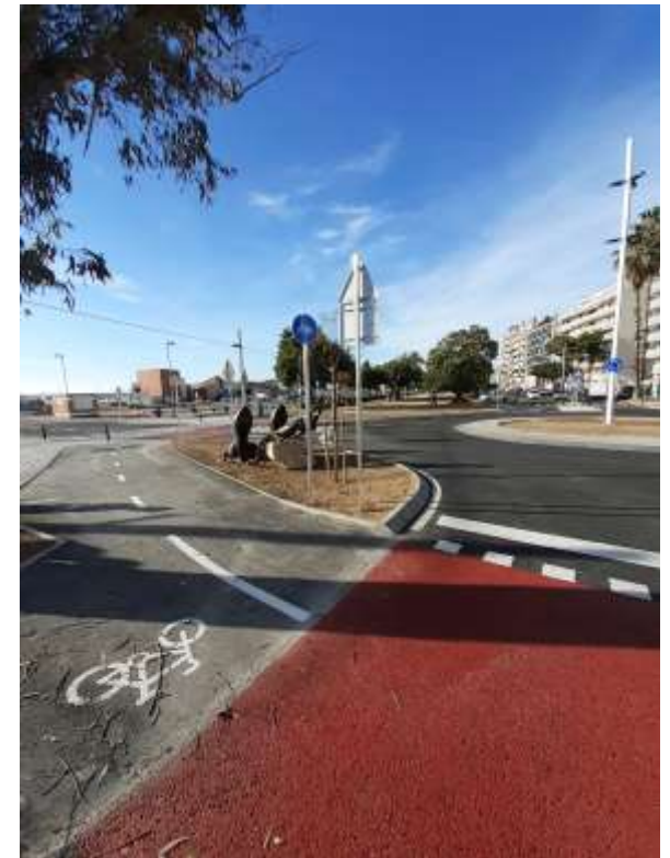
Fotografies. Rotonda acabada ↓
