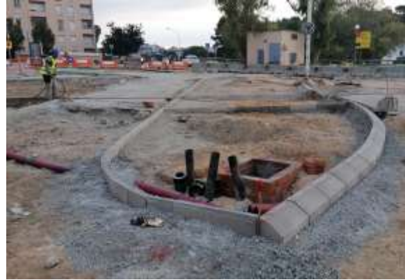
Col·locació de paviment podò-tàctil en els passos de vianants ↓
