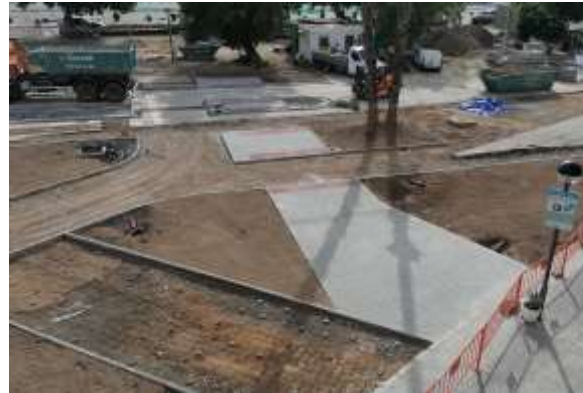
Col·locació de paviment podò-tàctil en els passos de vianants ↓
