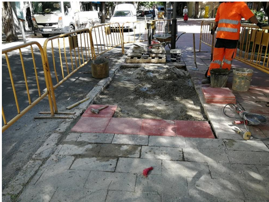
Reparació de la vorera
