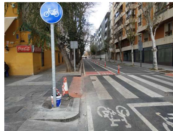
Fotografies de l'obra acabada ↓
