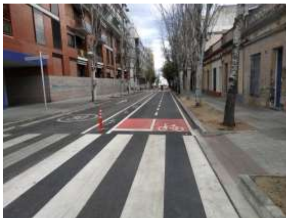
Fotografies de l'obra acabada ↓
