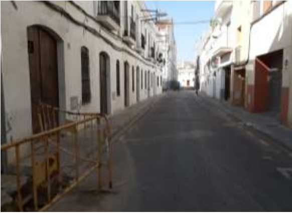
Abans de l'obra. Carrer de Sitges ↓
