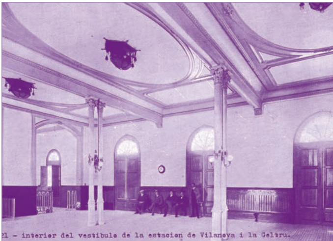
21 - interior del vestibule de la estacion de Vilanova i la Geltrú.
