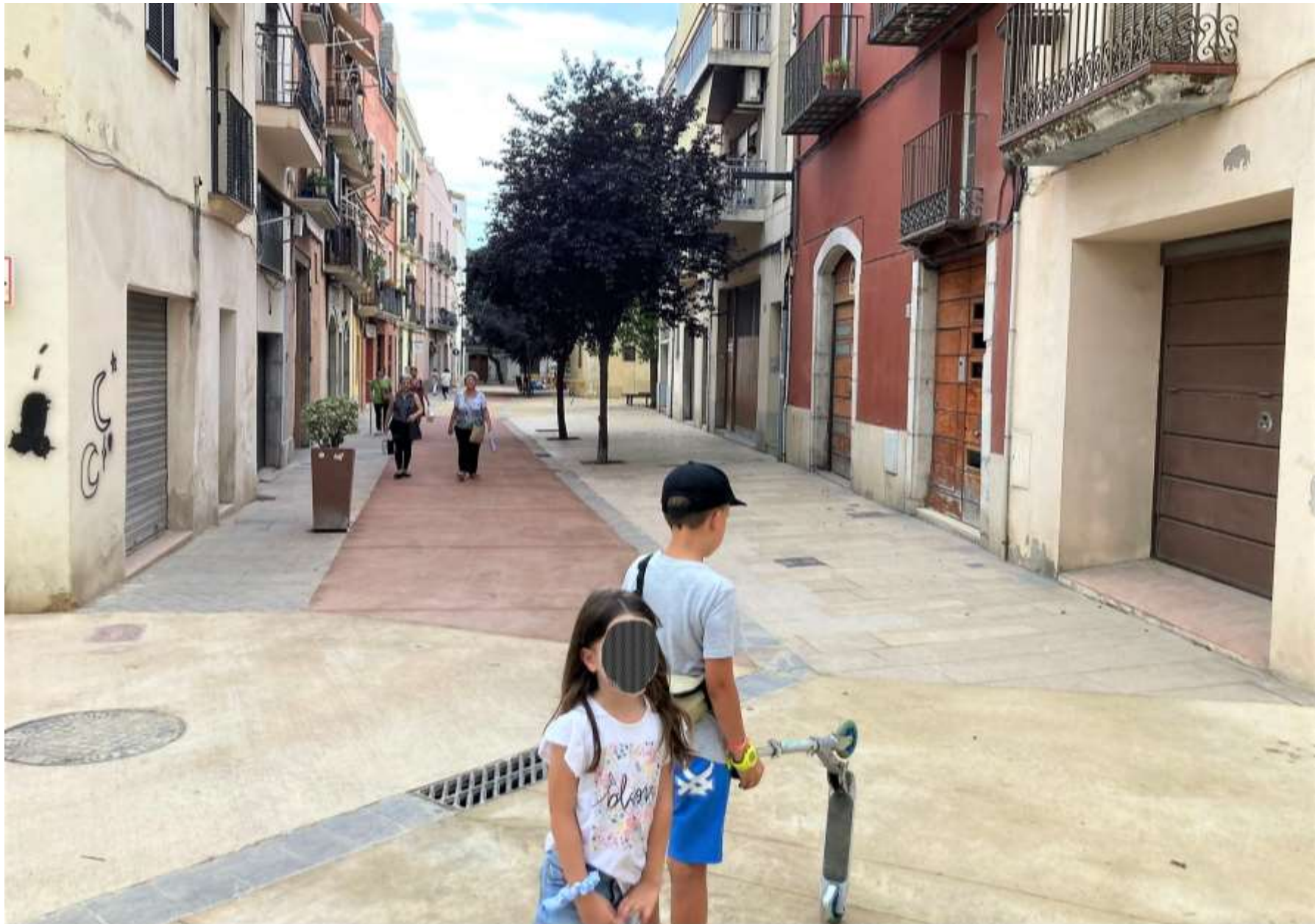
Plaça llarga. Obra acabada
