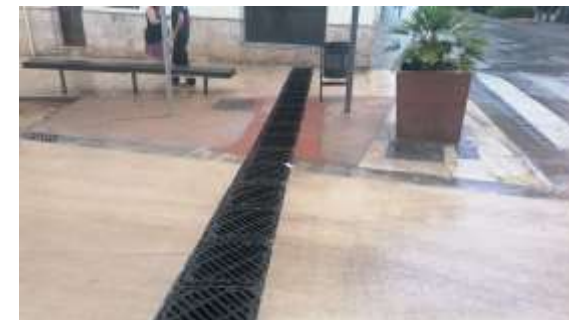
Fotografies de l'obra acabada ↓
