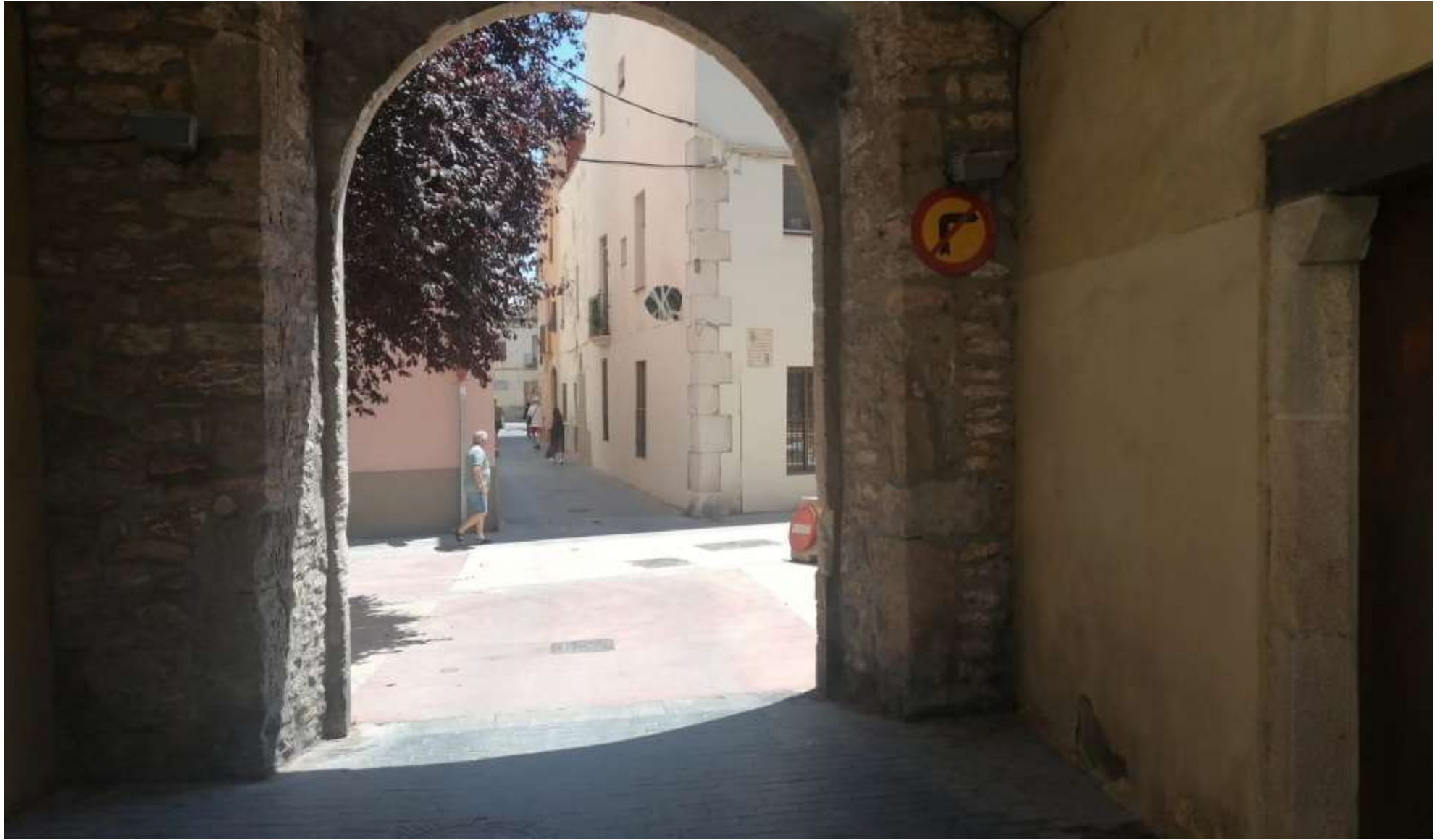
Plaça llarga. Obra acabada
